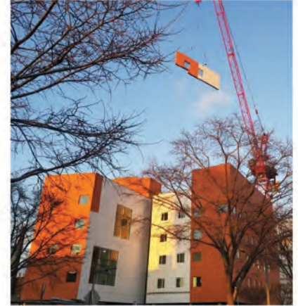
MIT Vassar Student Housing, Cambridge MA Steel framed Mega-Panels.
